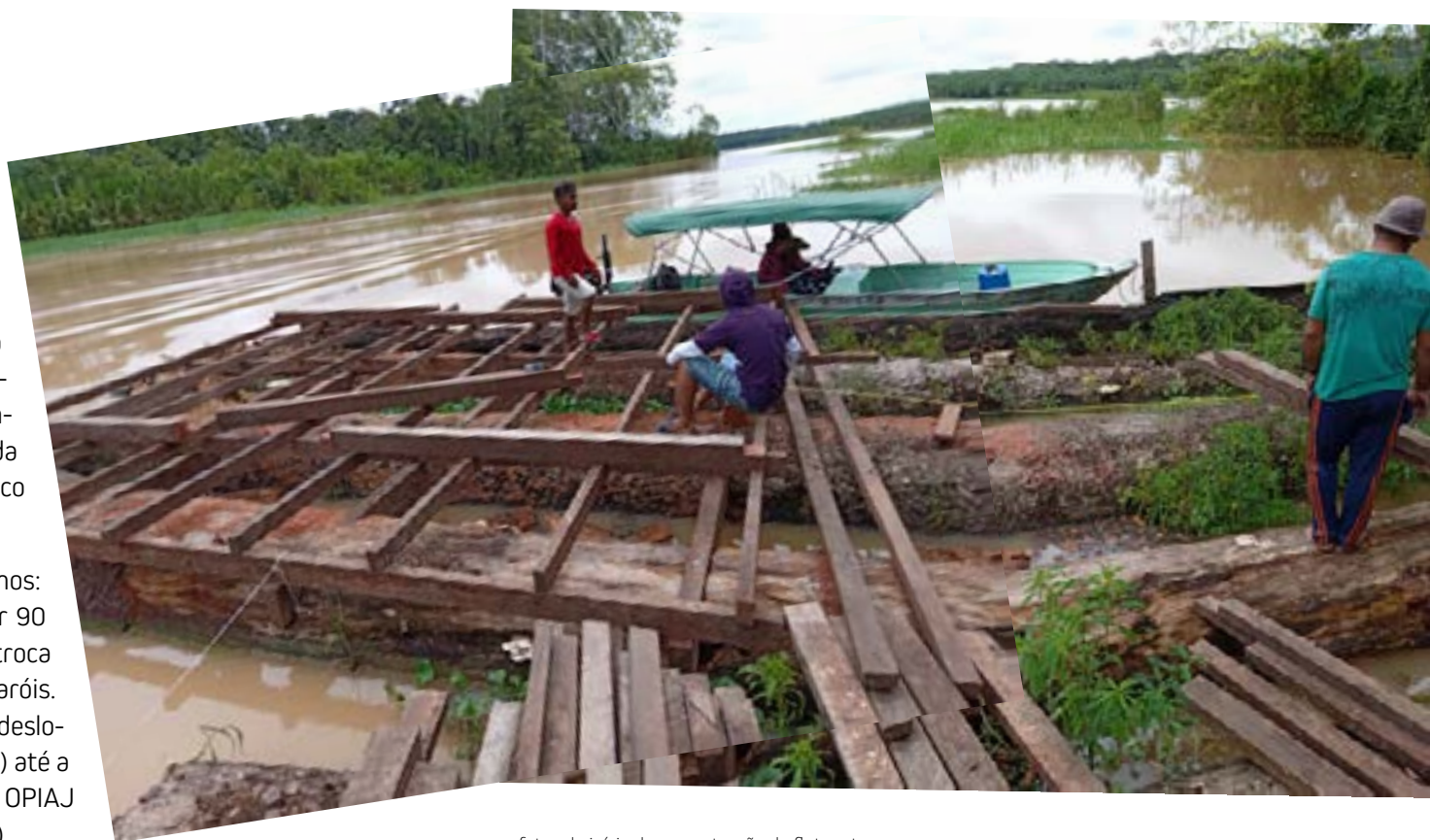
fotos do início da reconstrução do flutuante
